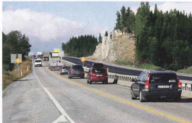
E6: Utbyggingen av E6 mener Vilrid Femoen er et eksempel på langtekkelig planleggingstid. Her fra byggingen mellom Espa og Kolomoen. FOTO: TRULS TUNMO
